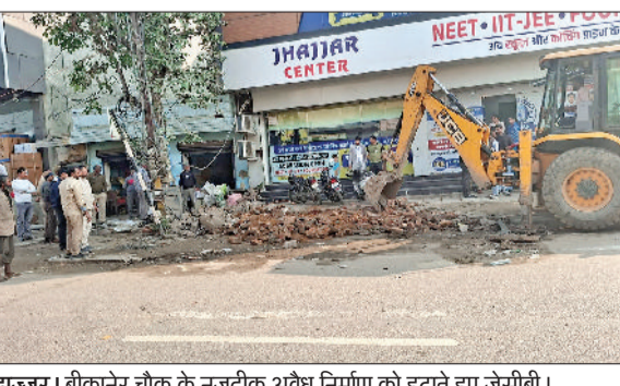
झज्जर। बीकानेर चौक के नजदीक अवैध निर्माण को हटाने हुए जेसीबी।
